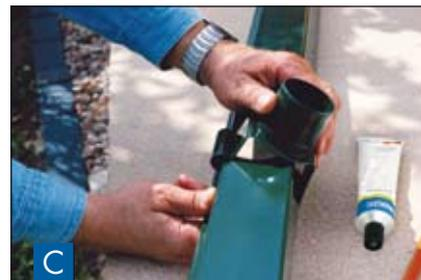
Nach dem Aufbringen des Klebers auf den Rinneinstützen sofort die Teile miteinander verbinden. Dazu Rinneinstützen über die hintere Abkantung einhängen und über den vorderen Wulst klippen.
