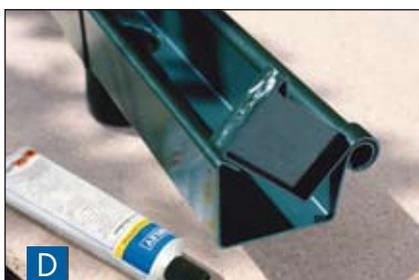
Die Endstücke vor der Verklebung ebenfalls gründlich reinigen und dünn mit Marley Spezialkleber einstreichen. Die Endstücke sind rechts oder links verwendbar.
