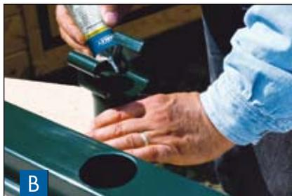
Den Rinneinstützen auf der Innenseite sowie die Dachrinne im Verklebungsbereich auf der Außenseite mit Marley Dachrinnen-Reiniger säubern und entfetten. Dann den Kleber auf der Innenseite des Stützens auftragen.
