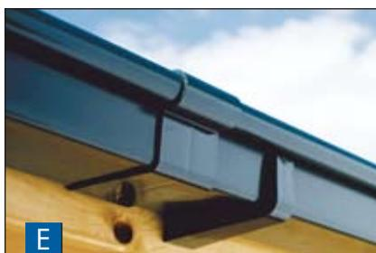
Bei der Verbindung von 2 Rinnenden muss die Verbindungsschale genutzt werden. Den Kleber auf die Innenseiten der Verbindungsschale aufbringen und die Rinnenden in die Verbindungsschale einschieben.
