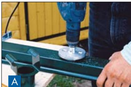
Das Loch für den Ablauf lässt sich am einfachsten mit einem Lochsäge-Aufsatz aussägen. Für alle Sägearbeiten gilt: Die Kanten müssen vor der Verklebung gründlich entgratet werden.
